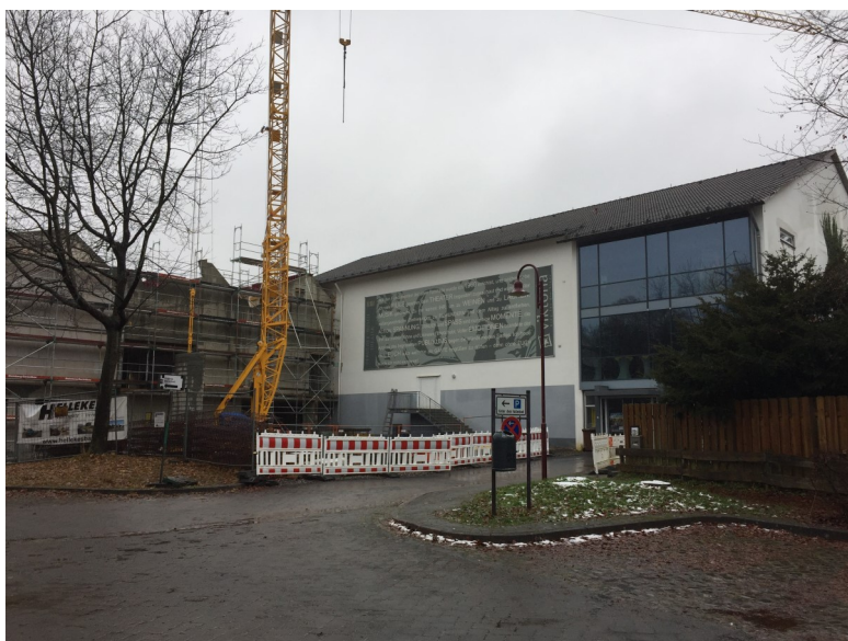
Nach langer Planungszeit endlich Baubeginn am Kulturellen Marktplatz
